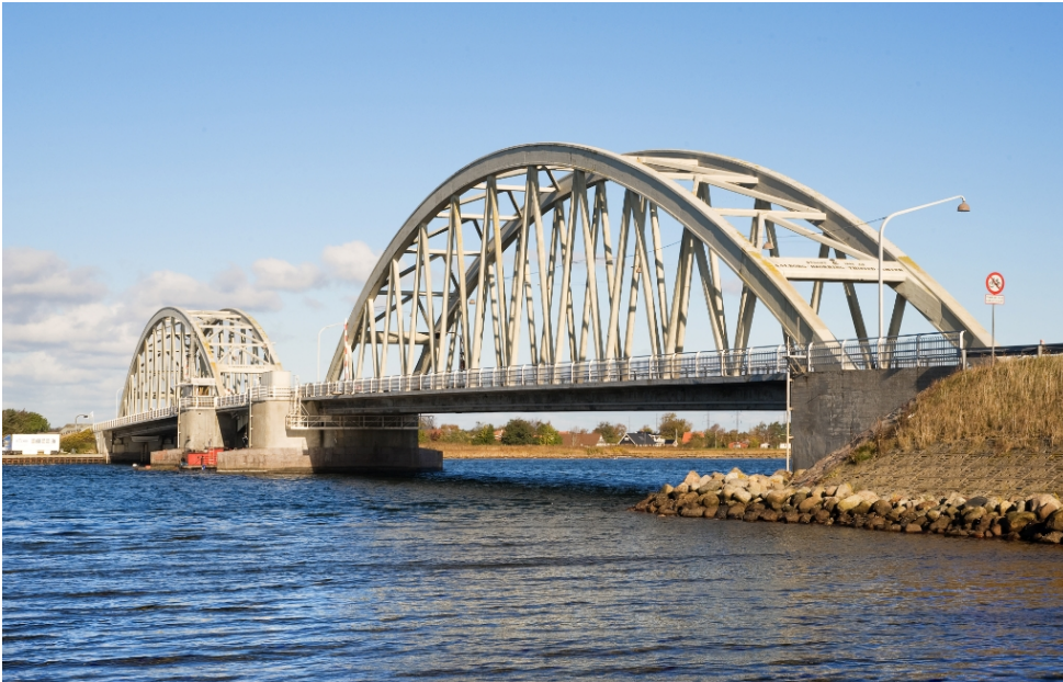
Aggersundbroen over Limfjorden var en af 1930'ernes store broer i Danmark. Den var projekteret af rådgivende ingeniør, dr.techn. Christen Ostenfeld. Den 218 m lange bro blev bygget i perioden 1939-1942.
