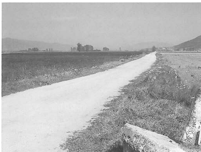
Fig. 7. Via Egnatia, hovedvejen fra Albanien til Tyrkiet, fotograferet øst for Thessaloniki. Romerske veje var normalt kun brolagte, hvor de var udsat for stærkt slid — dvs de største hovedveje, indfaldsvejene til de store byer og veje med stærk stigning. Størstedelen af vejnettet var, som her, grusbelagt. (Foto: TBN).
