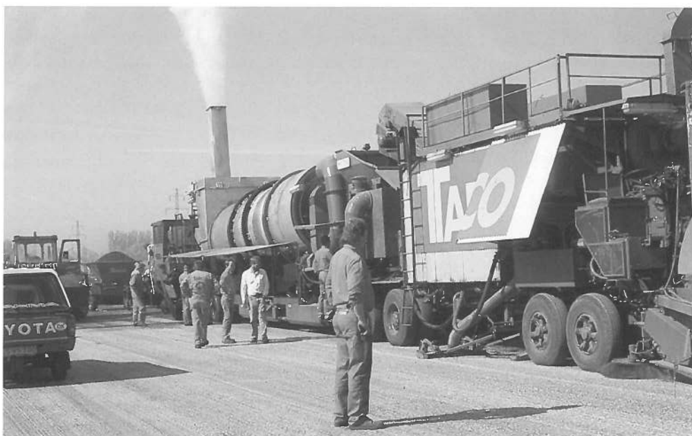
Fig. 11. Genbrug af asfalt er en metode, der sparer ressourcer og er økonomisk fordelagtig. Foto: Vejdirektoratet.
