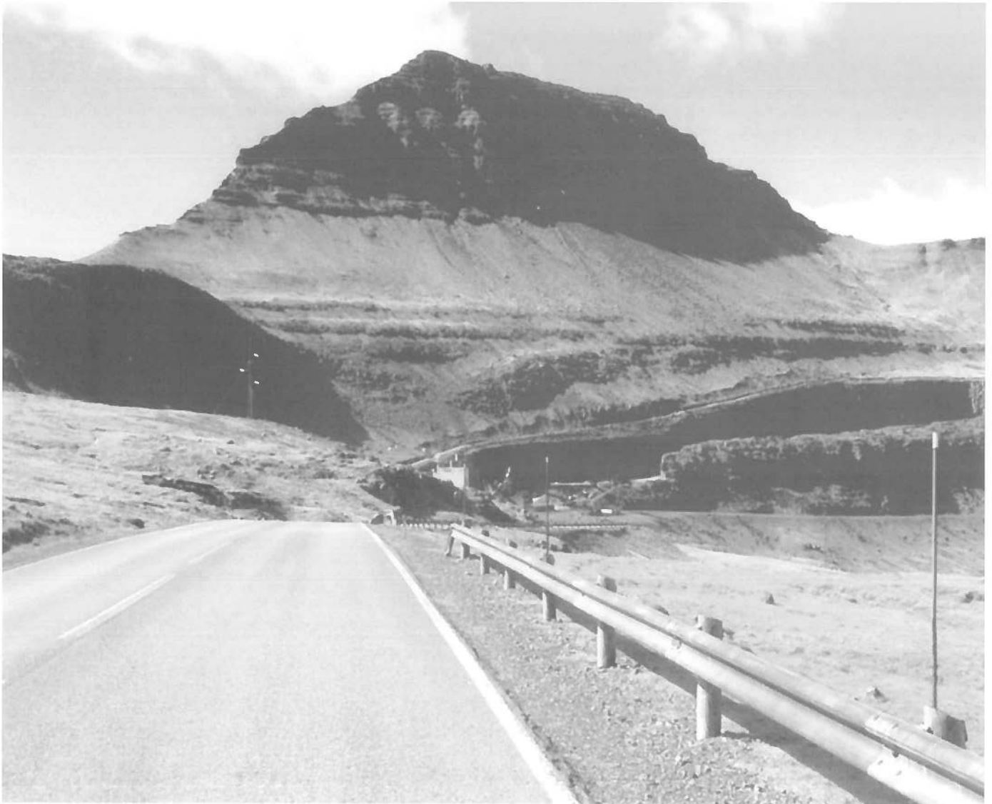
Fig. 23. Hundsarobotnur neden for det 767 m høje Skællingsfjall med landets største stenbrud, skærve- og asfaltværk, som siden 1965 har udspyt byggematerialer til det færøske vejnet. Foto: HO.
