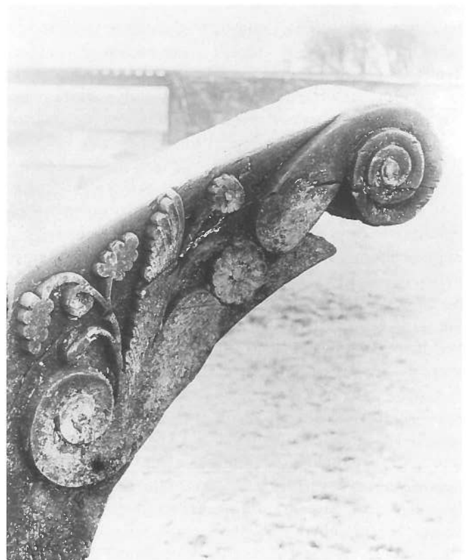
Fig. 2. Detalje af rækværket på Anst bro, opført omkring 1600, og nedrevet i 1900. Foto Nationalmuseet.
