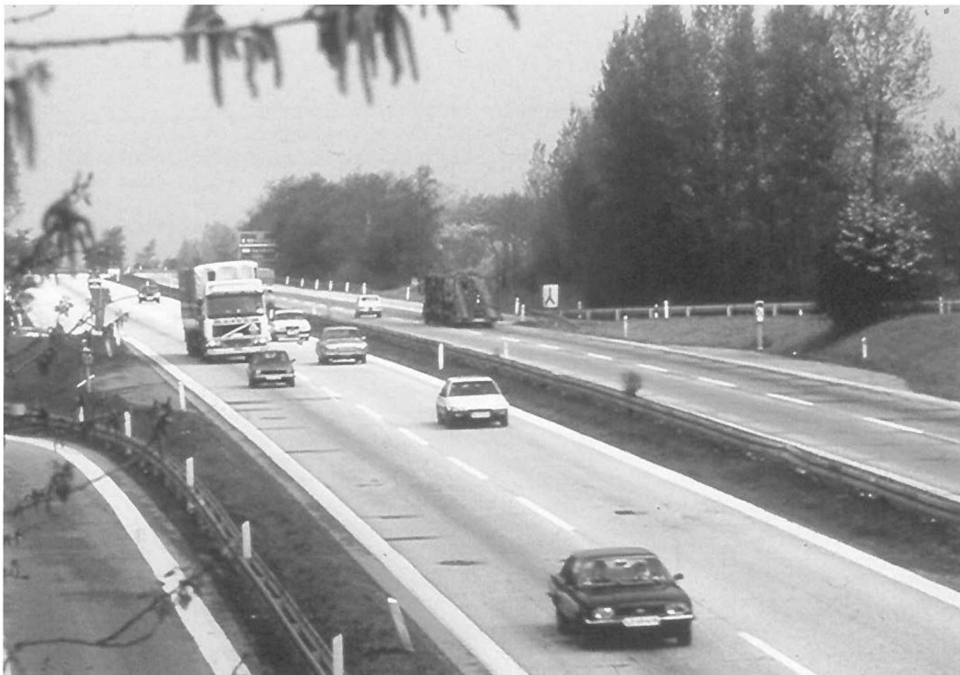
Fig. 4. Hørsholmvejen ved udfletningen ved Sandbjerg en gang i 1970'erne. Foto: CJH.
