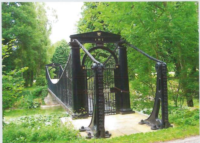
På DVS' tur på Fyn i 1999 besøgte deltagerne bl.a. den smukke hængebro over voldgraven på Brahesborg Slot ved Assens. I midten af 1800-tallet blev jernbroer noget af et modefænomen på danske herregårde og hængebroen på Brahesborg blev i 1850 støbt på det norske jernværk Fritzøe og herefter fragtet til Danmark.
