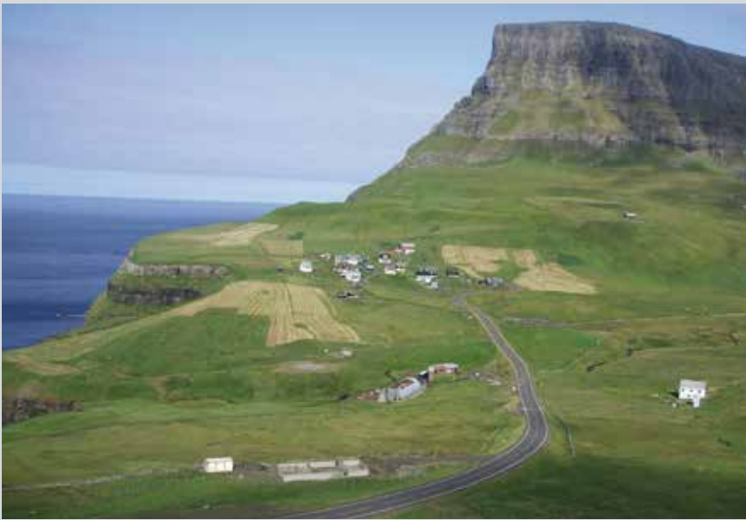
Fig. 2. Udsigt til Gásadalur og den anlagte tosporede vej. Foto: Ulrik Blindum.
