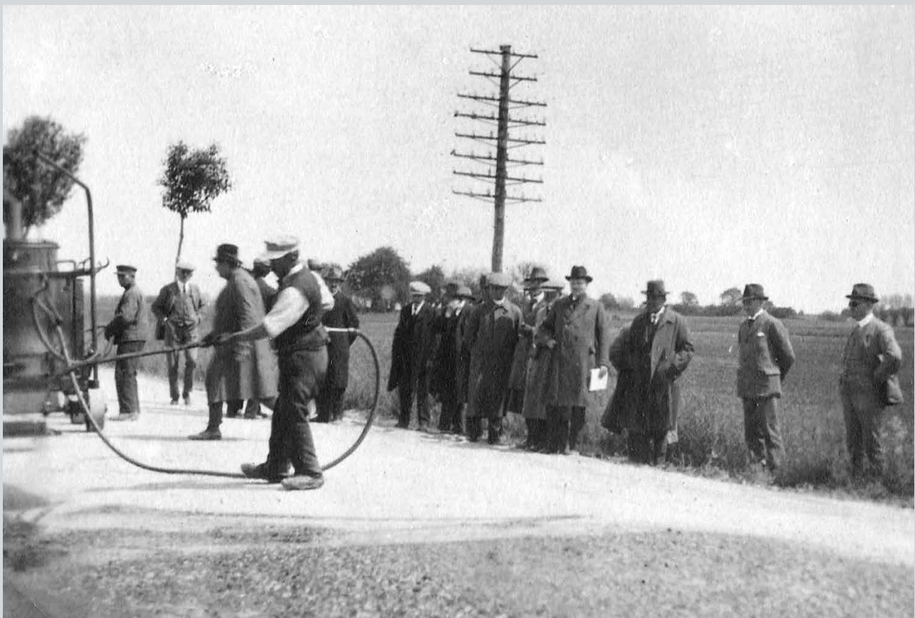
Fig. 9. Løsningen på problemet med de vejødelæggende hurtige bilhjul var ret simpel. En overfladebehandling kunne holde på sandet, som her hvor landets amtsvejsinspektører ser på automatisk tjærebehandling i 1920. Kort efter var en stor del af landets veje blevet behandlet, og restriktionerne kunne løsnes. Foto: Danmarks Vej- og Bromuseum.
