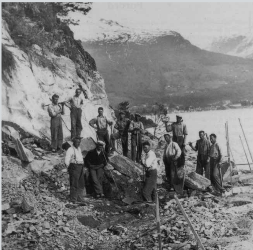
Fig. 2. Vejarbejdere i Norge i 1930'erne. Den gang var arbejdet på vejene meget arbejdsintensivt. Foto: Statens vegvesen, Norge.
