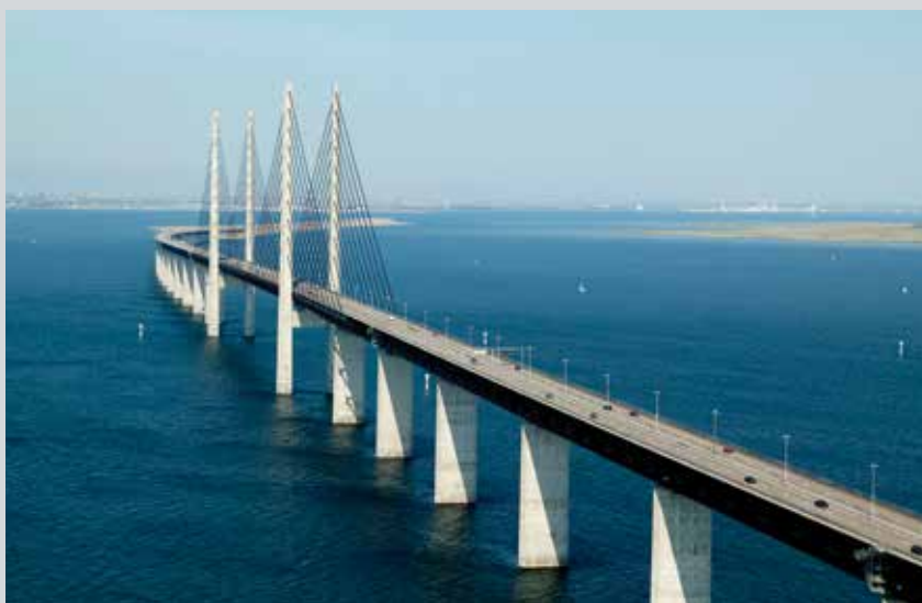
Fig. 11. De nordiske lande forbindes ofte af store broer som Øresundsbroen mellem København og Malmø, der blev åbnet 1. juli 2000. Broens totale længde er 7.845 m, hvoraf skråstagsbroen er 1.092 m. Foto: Øresundsbrokonsortiet.
