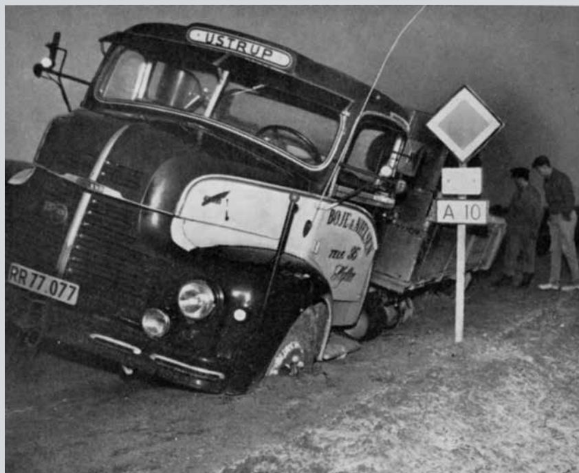
Fig. 14. Vejene kunne undertiden bryde sammen under de tunge køretøjers vægt. Det skete især ved vintertøbrud om foråret, som her ved Hovedvej 11 i 1963. I en årrække var der næsten hvert år perioder med forbud mod at køre med tunge køretøjer på nærmere angivne landeveje. Foto: Dansk Vejtidskrift.
