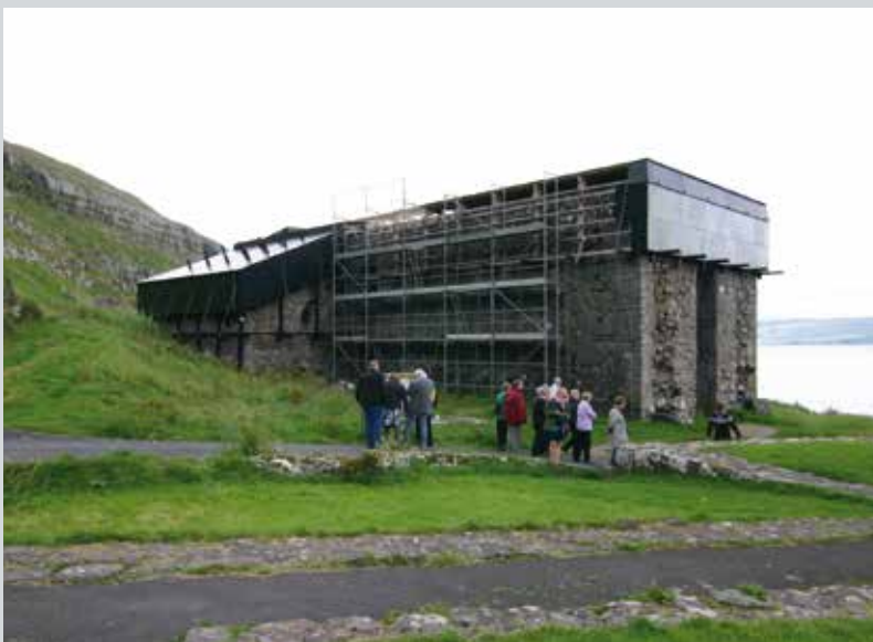
Fig. 5. Ruinen, også kaldet "muren" af den ufuldførte domkirke i Kirkjubø. Den er indenfor de sidste år blevet iført et beskyttende stillads og tag, som forhåbentlig snart fjernes. Foto: Ulrik Blindum.
