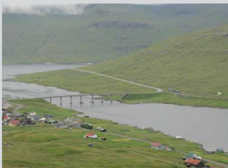
Fig.10. "Atlantehavsbroen" mellem Streymoy og Eysteroy er den eneste bro over Atlanterhavet. Broen er 220 m lang og opført 1971-1973 af firmaet E. Pihl & Søn. Foto: Carl Johan Hansen.
