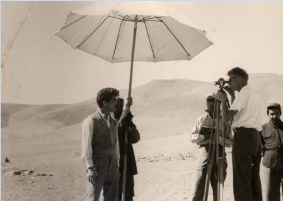
Vejlinien udstikkes. Per Milner tachymetrerer på strækningen mellem Kangavar og Ashadabad i oktober 1956. Fra venstre mod højre ses en arbejdsformand, en parasolbærer, Milners sekretær Nasser og herefter chaufføren.
