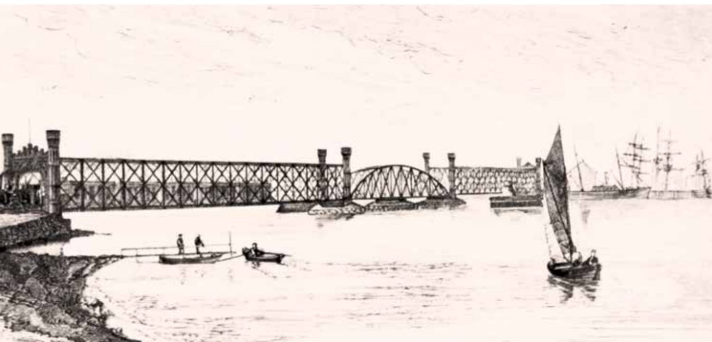
Jernbanebroen over Masnedsund var i brug fra 1884 til 1937. Den var 182 m lang og den næstlængste bro i Danmark, kun overgået af Limfjordsbroen.
