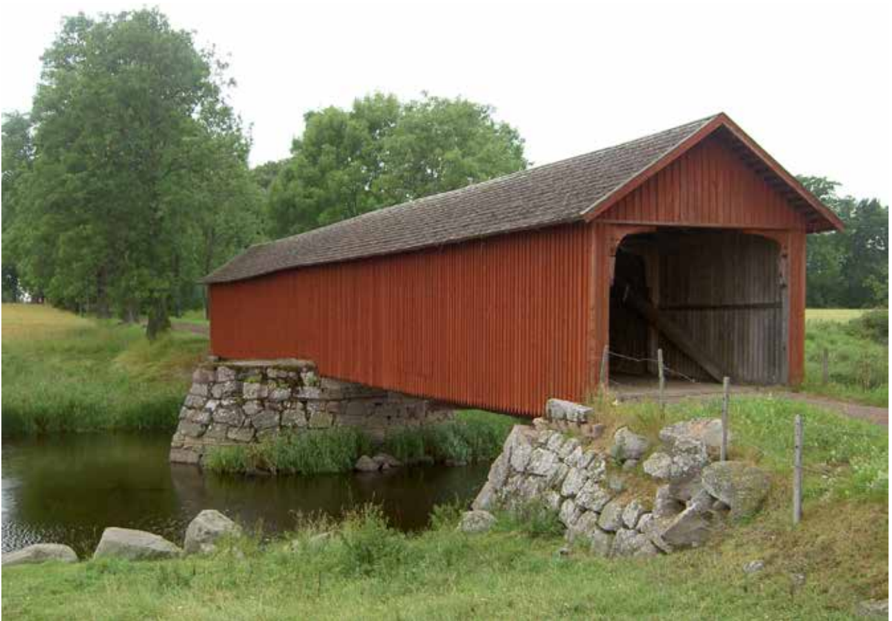
Vaholms bro, efter restaureringen. Foto Jan-Olof Montelius 2005.
