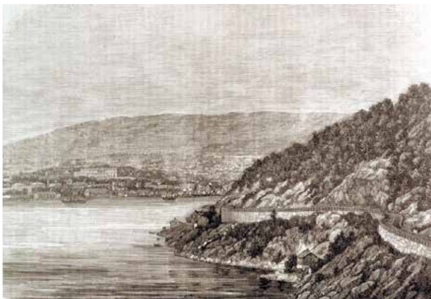
Ljabruchausseen. Kongevegen mellom Christiania og Østfold løber langs Oslofjorden. Den første vegen etter det nye vegbyggingprinsippet om „Bøttehanken ned“ i Norge. Svennestykket til den senere veiasistent/veidirektør Christian Wilhelm Bergh.
