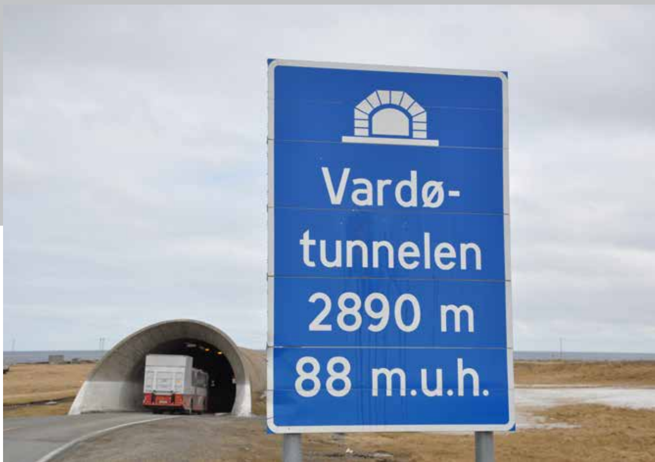
Vardø-tunnelen i Finnmark var den første undersjøiske tunnelen i Norge da den åpnet i 1982. Siden er det blitt en vanlig løsning der forholdene ligger til rette for det. Foto Henriette Erken Busterud, Statens vegvesen
