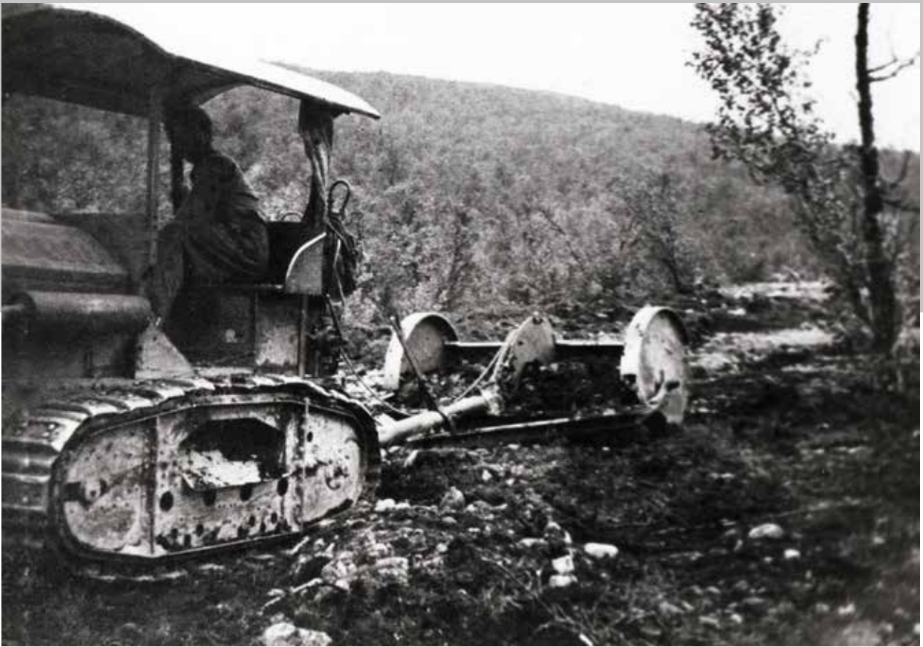
I vedlikeholdet ble et etter hvert vanlig både med lastebiler og veiskraper. Men anlegg var fortsatt spase og trillebår. Det ble så vidt gjort noen forsøk med beltetraktorer før krigen ved anlegg, men bulldoser ble ikke vanlig før på 1950-tallet. Denne beltetraktoren er brukt i Lebesby i Finnmark i 1939. Foto Norsk vegmuseum arkiv
