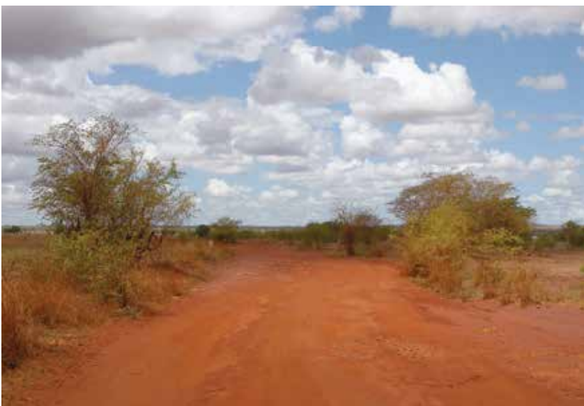
De fleste veje i Ghana er simple jordveje. Den røde farve skyldes jordarten laterit. Navnet betyder mursten på latin, og vejen er da også hård i tør tilstand, men meget blød i regntiden. Foto Frank Vassen.
