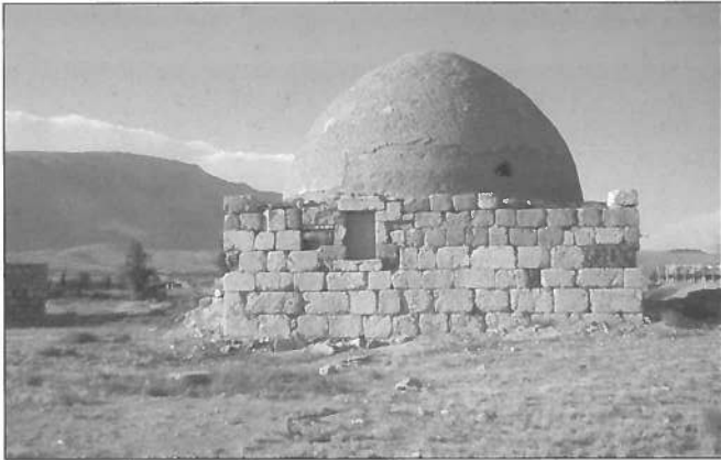
Fig. 13. Khan Aiyash lige nord for Damaskus kaldes også "relais de la Citerne" efter den store kuppeloverdækkede cisterne, der indgår i khan-komplekset. Ligesom selve stationen er den bygget i slutningen af 1100-tallet.
