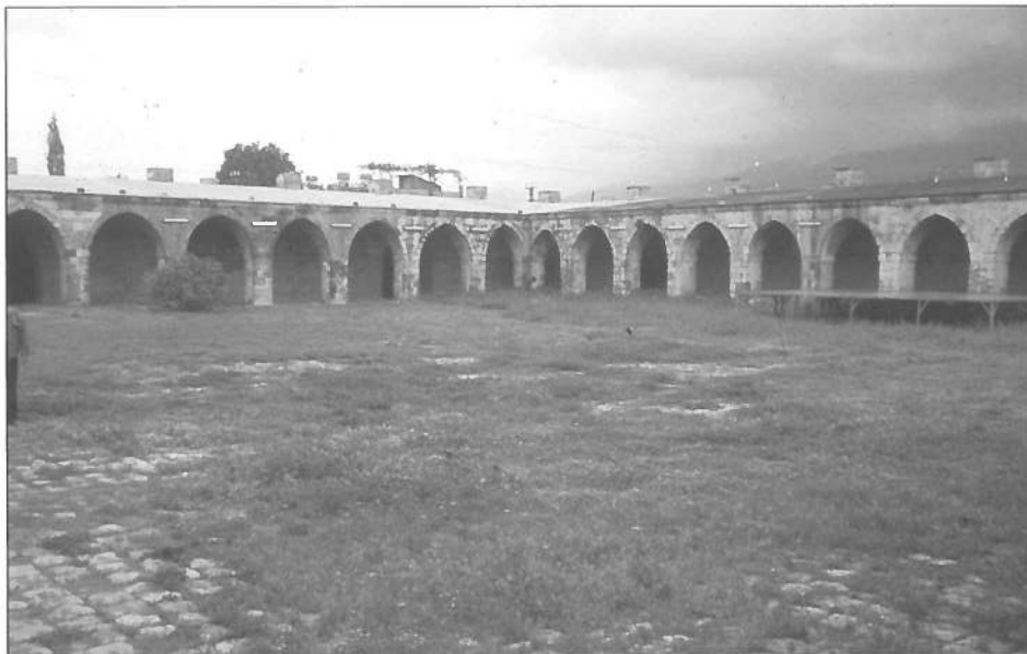
Fig. 8. Den store gård i Yakaciks karavanestation er omgivet af gallerier på tre sider. Hvert fag rummer to dele: et overdækket ydre rum hvor dyrene kan stå og et lukket, indre rum med ildsted.
