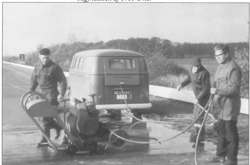
Fig. 4. Nedfræsning af spoler på Sydmotorvejen på Lolland i begyndelsen af 1960'erne.
