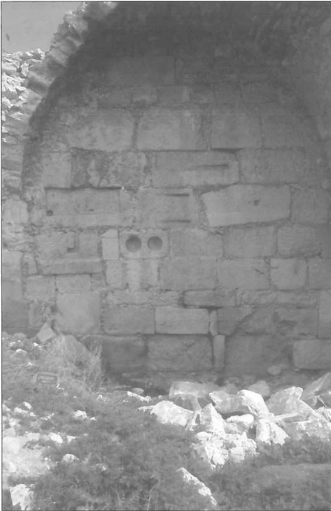
Fig. 2. Et hjørne af hallen set indefra. Overalt i Sadeddin han støder man på spolier, genanvendte byggematerialer fra ældre bebyggelse på stedet.
