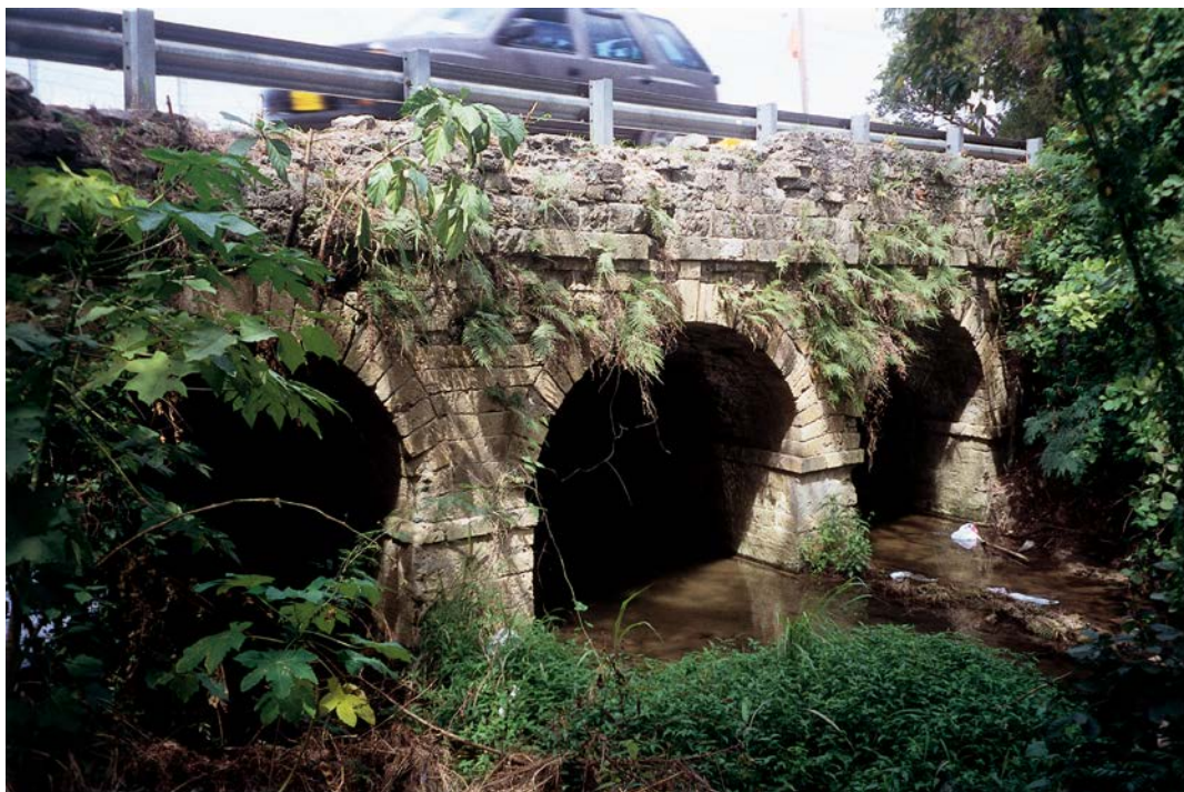
Broen fra 1909 er opført af vejinspektør Ejnar Kærn. Broen er konstrueret af tilhuggede koralsten.
