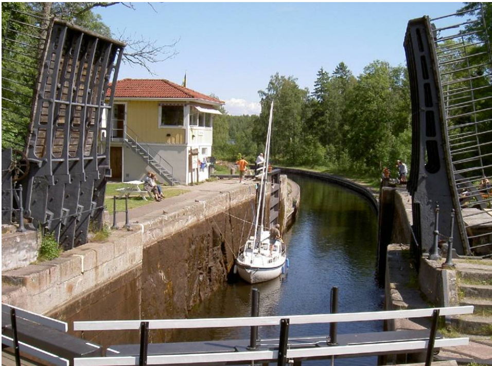
Sveriges ældste jernbro fra 1813. Det er en klapbro, som fører over Göta kanal i Forsvik.
