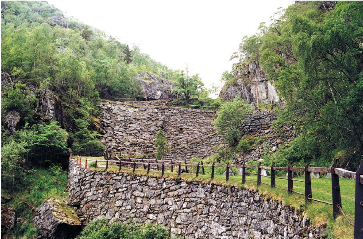
Vindhallavegen ved Lærdal ligger på Den bergensiske Kongevej mellem Oslo og Bergen og var en af Norge vigtigste veje. Den flotte støttemur på vejen er bygget i 1840'erne. På turen skal vi spadsere på Kongevejen netop på dette sted. Foto: Cathrine Thorstensen, Norsk vegmuseum.
