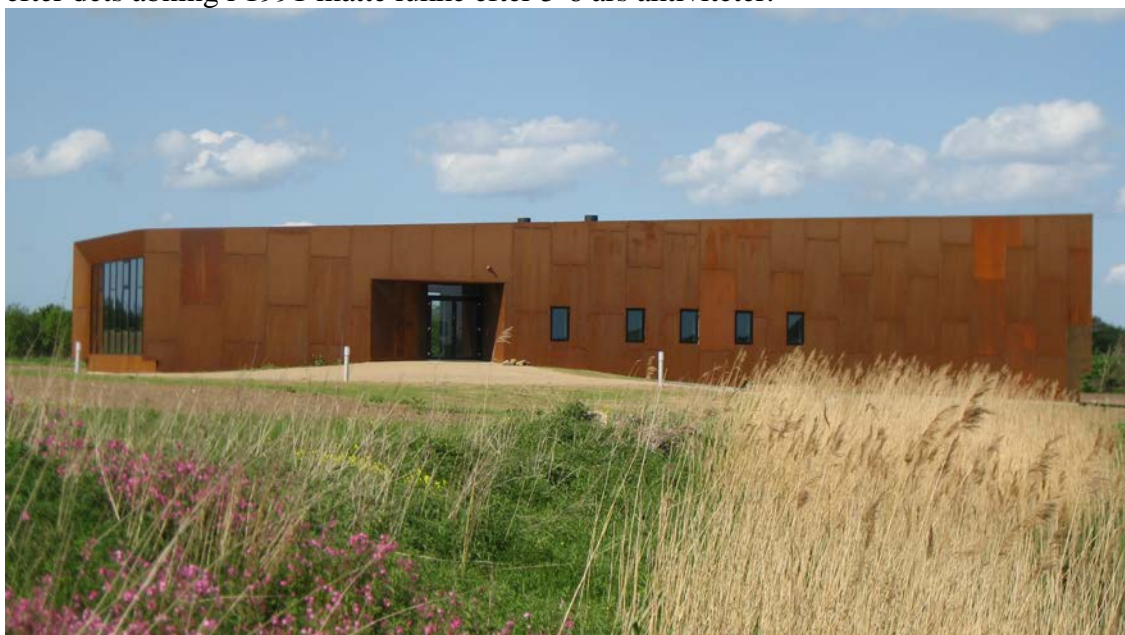
Vej- & Brohuset er en flot og markant bygning i landskabet. Huset er beklædt med stålplader, som i løbet af 2011 rustet til en krakteristisk dyb rødbrun farve. Foto: Berit Stage, DVB.
