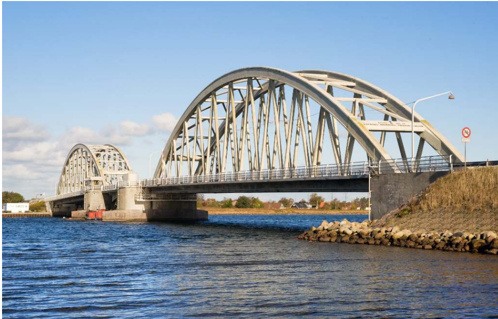
Aggersundbroen over Limfjorden var en af 1930'ernes store broer i Danmark. Den var projekteret af rådgivende ingeniør, dr.techn. Christen Ostenfeld. Den 218 m lange bro blev bygget i perioden 1939-1942.
