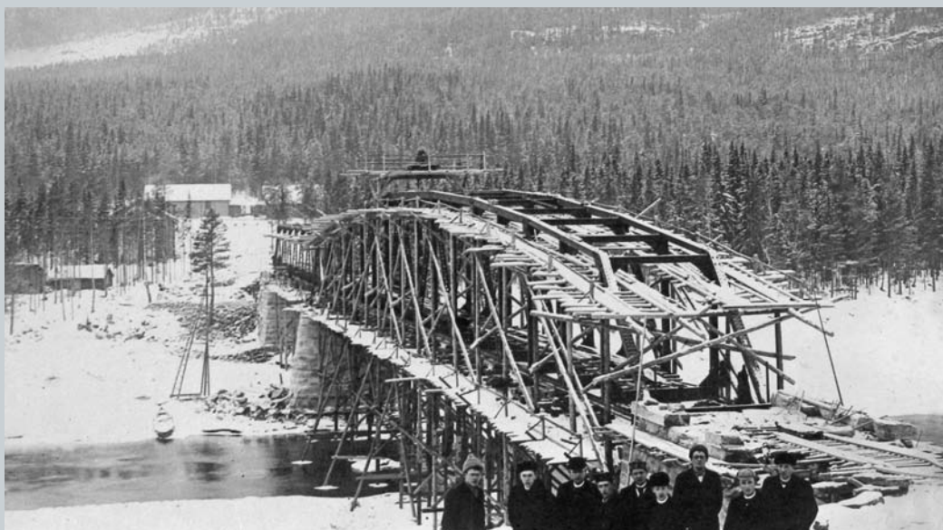
Fig. 6. Tretten bru under bygging, 1895
