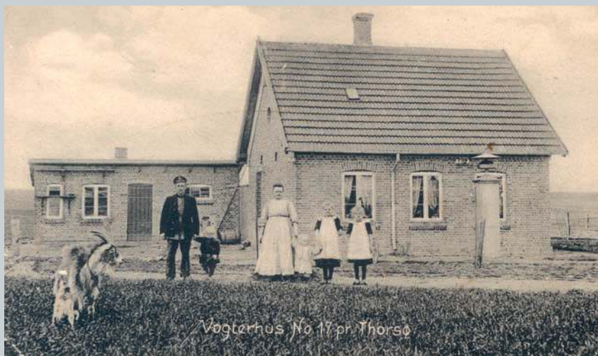
Vogterhus No 17 mellem Fårvang og Thorsø på banen Laurbjerg-Silkeborg-Bramming før første verdenskrig. Foruden banevogteren, i uniformsjakke og med kasket og med den lille søn i hånden, ses hustruen, der var den, der i praksis passede leddet, mens manden passede sporet på strækningen. Hun med et mindre barn ved hånden og to døtre. Foran huset ses meldeklokken, hvis signal angav kommende tog, og at leddet derfor skulle lukkes. Postkort. Danmarks Jernbanemuseum
