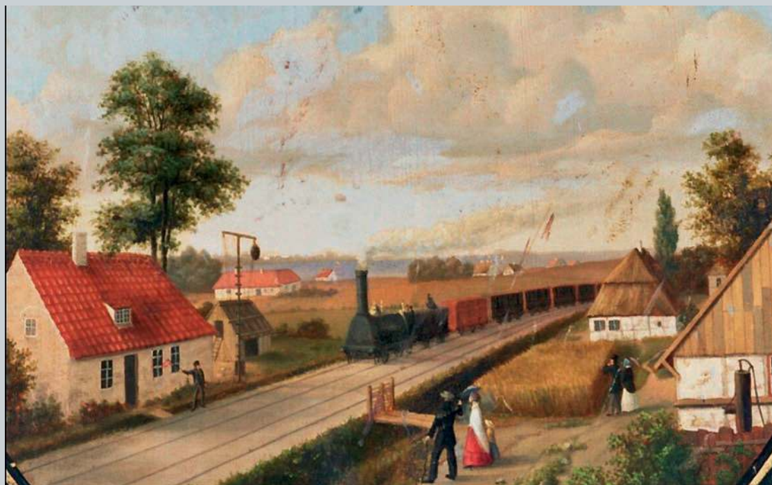
Vogterhuset ved Vester Fælledvej ved København på O.F.A. Busse (den ældres) skydeskive fra 1854. På signalmasten er hejst én kurv, som angivelse af togets kørselsretning mod København. Banevogteren giver med flag signal til loko-motivføreren om, at banen er farbar. Leddet er da også lukket. Bagest på tenderen (kulvognen) skimtes "togsmeden", der sad på en stol med ansigtet bagud, for at holde øje med, om toget tabte vogne. Selv om der er to spor på billedet, var banen ikke dobbeltsporet i driftsmæssig forstand, således at man kørte i den ene retning på det ene spor og i den anden retning på det andet. Kun fra København til Valby var der to spor. Det ene brugtes til trafikken København-Roskilde. Det andet brugtes til udflugts-togene til Søndermarken og Frederiksberg have. Udsnit af skydeskive. Det kongelige Skydeselskab, Sølyst.
