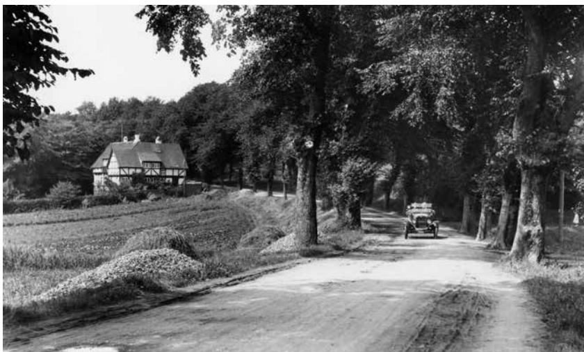
Endnu i 1923 ligger Næstvedvej ved Slagelse mellem statelige vejtræer med sin grusbelægning. Automobilets indtog medførte i første omgang, at grus og skærver udskiftedes med fast belægning, og i anden omgang at vejtræerne blev 'trafikfarlige'. Foto: Dansk Veteranbil Klub.
