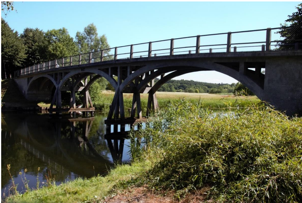
Amtmand Hoppes Bro i Langå fra 1905 – Danmarks første vejbro af jernbeton.
