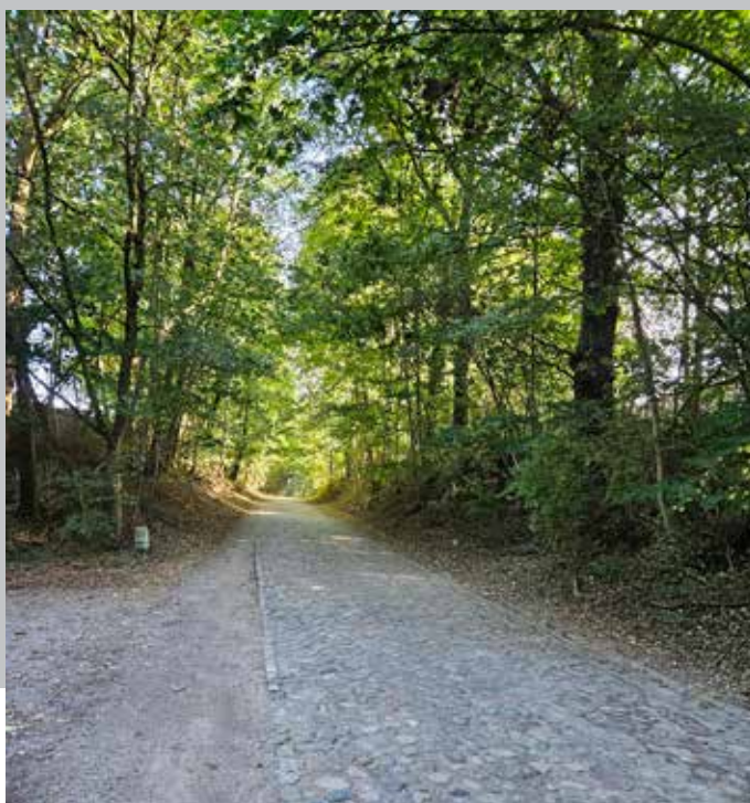
Fig. 8: Hohenfelder Damm. I venstre side ses den grusbelagte sommervej. FOTO: ULRIK BLINDUM.
